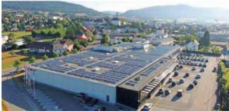
L'une des installations photovoltaïques qui a participé au bon résultat de l'an dernier de la ville de Delémont.
