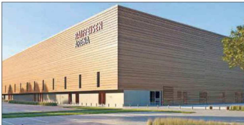
La future centrale photovoltaïque de la patinoire de Porrentruy voit les investisseurs se bousculer.
