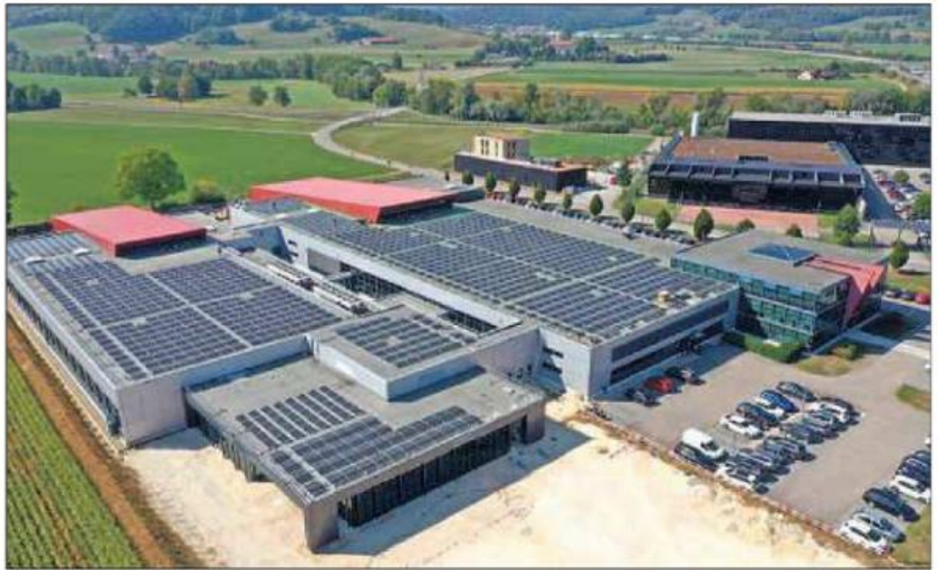
Les toits de l'usine Willemin-Macodel, dans la zone industrielle de la Communance, accueillent la plus grande installation photovoltaïque de la ville, opérationnelle depuis la semaine dernière.
