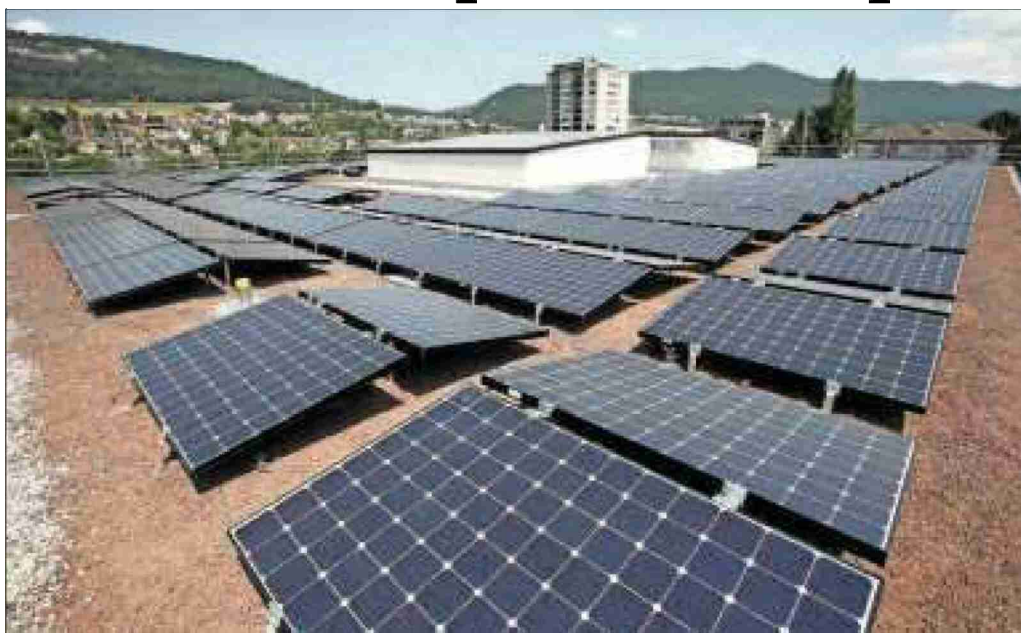
La centrale photovoltaïque installée sur le toit du bâtiment scolaire en construction à la rue de l'Avenir 33, à Delémont, a été mise en service la semaine dernière.
